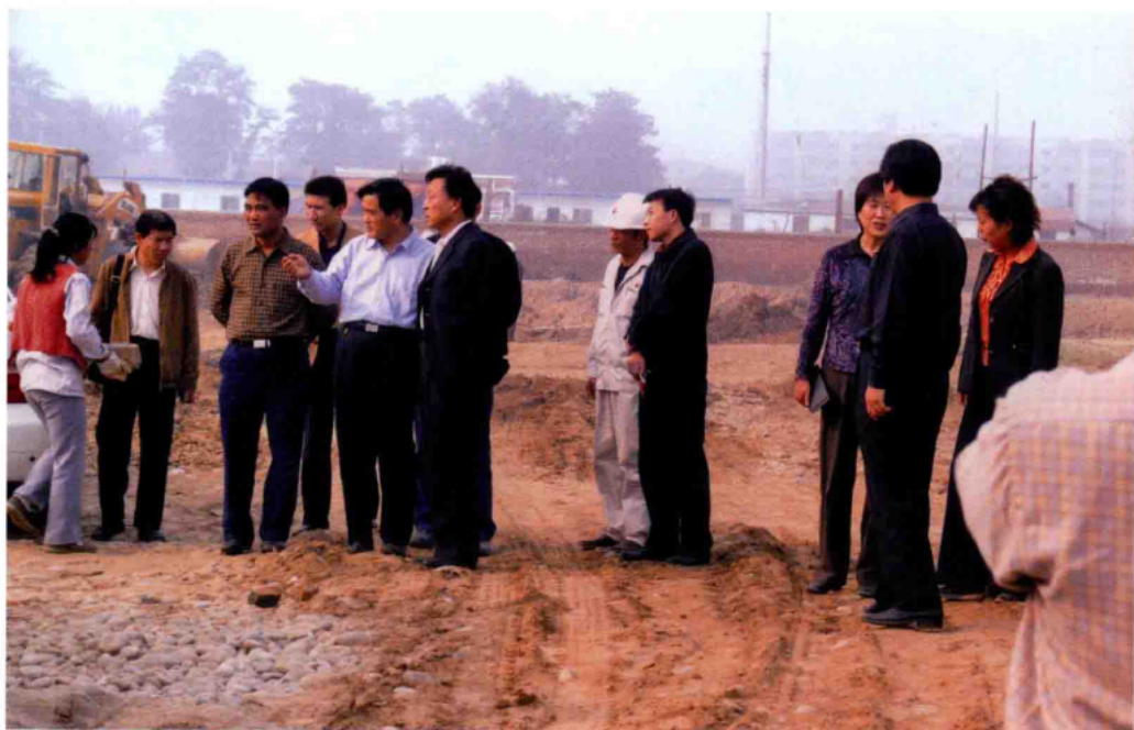
2006年10月，咸阳市常委、副市长李效民（前排左六）莅临公司石化项目工程现场检查指导工作
