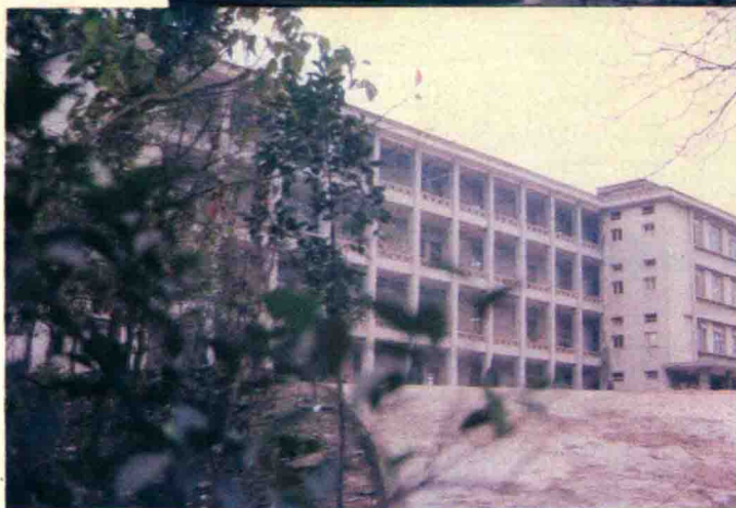
永川中学教学大楼
