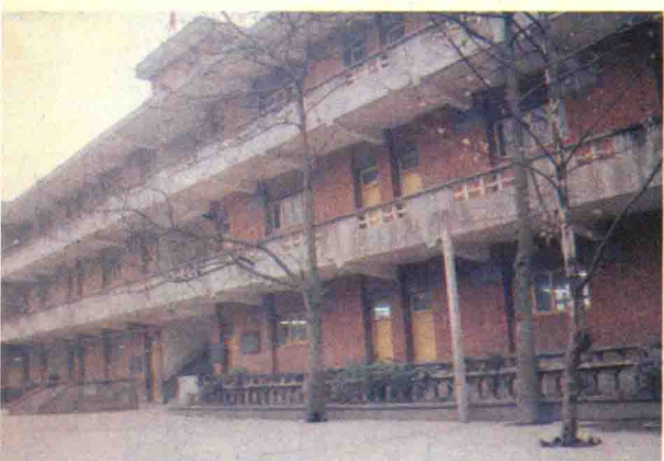
中山路小学教学大楼
