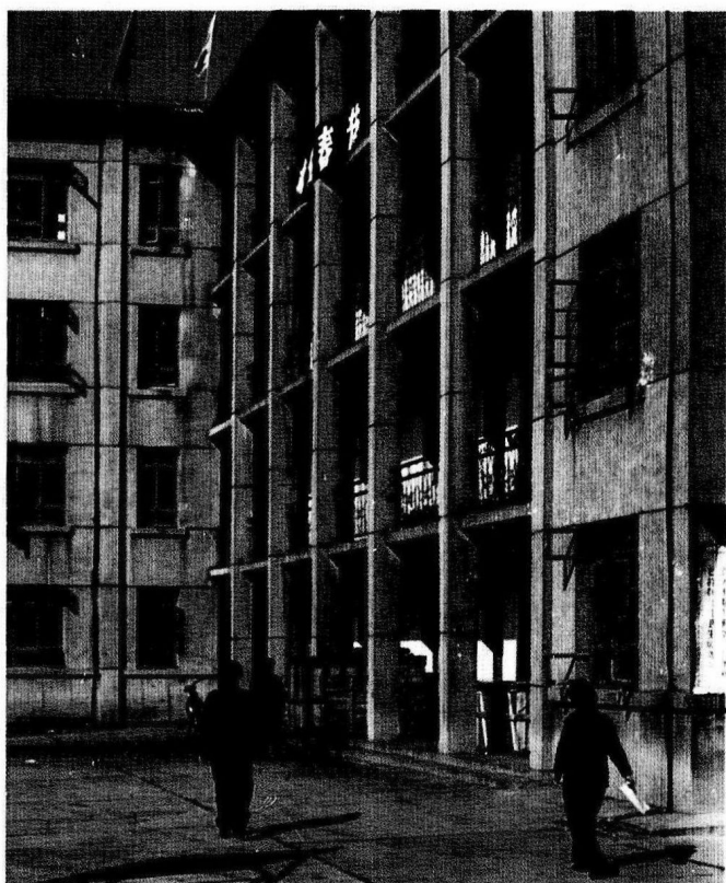
州药检所与州卫生局办公楼一角。（州卫生志编写组供稿）
