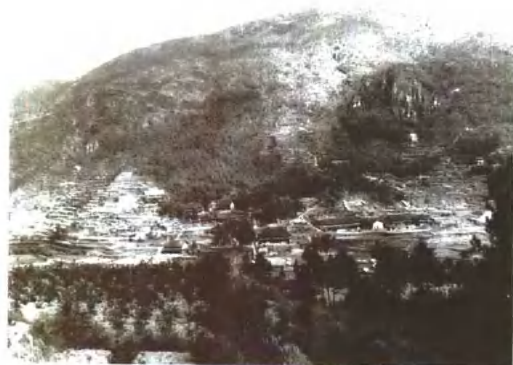
立三同志根据地指挥所旧址
