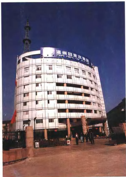
自 来 水 集 团 公 司 综 合 楼
