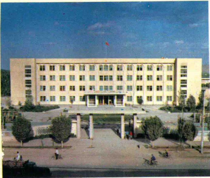
县人民政府联合办公大楼
