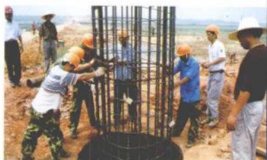
2003年6月18日，藏龙大桥打下第一根桩基
