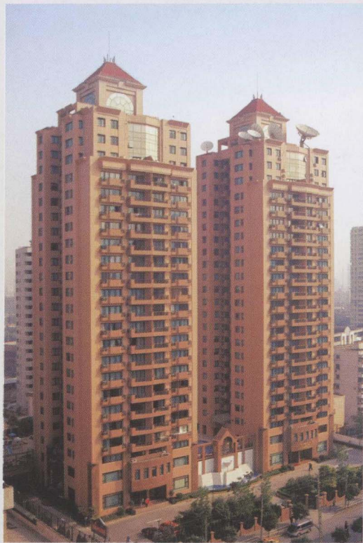
上海法华苑高级商住楼（鲁班奖工程）
