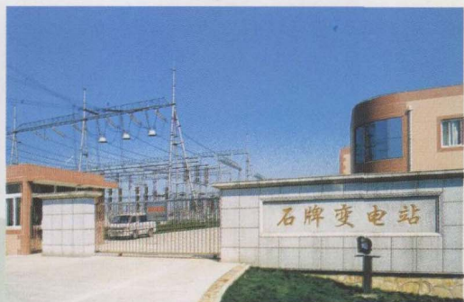
500KV 石碑变电站 (2003 年度鲁班奖)
