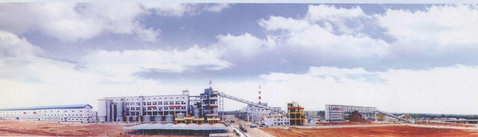
缅甸大巴日产200吨纸浆厂项目全景
