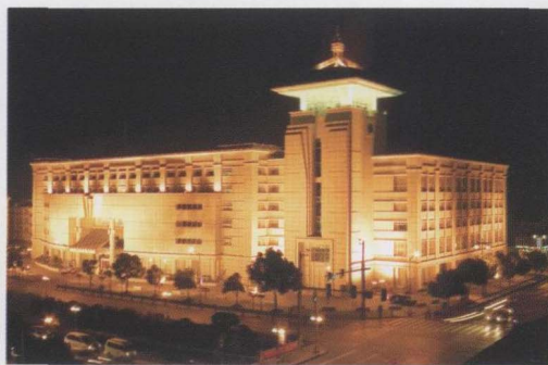
苏州国税综合业务大楼 (2004 年度鲁班奖)
