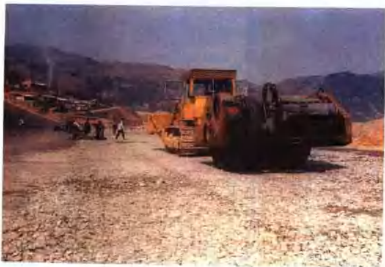
大坝压实施工
