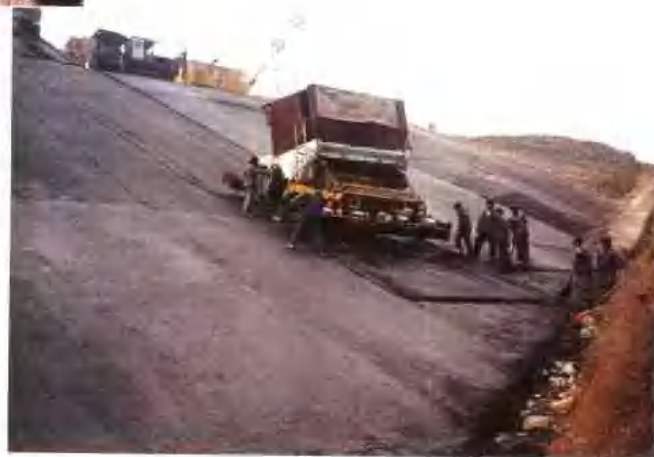
沥青砼斜墙施工
