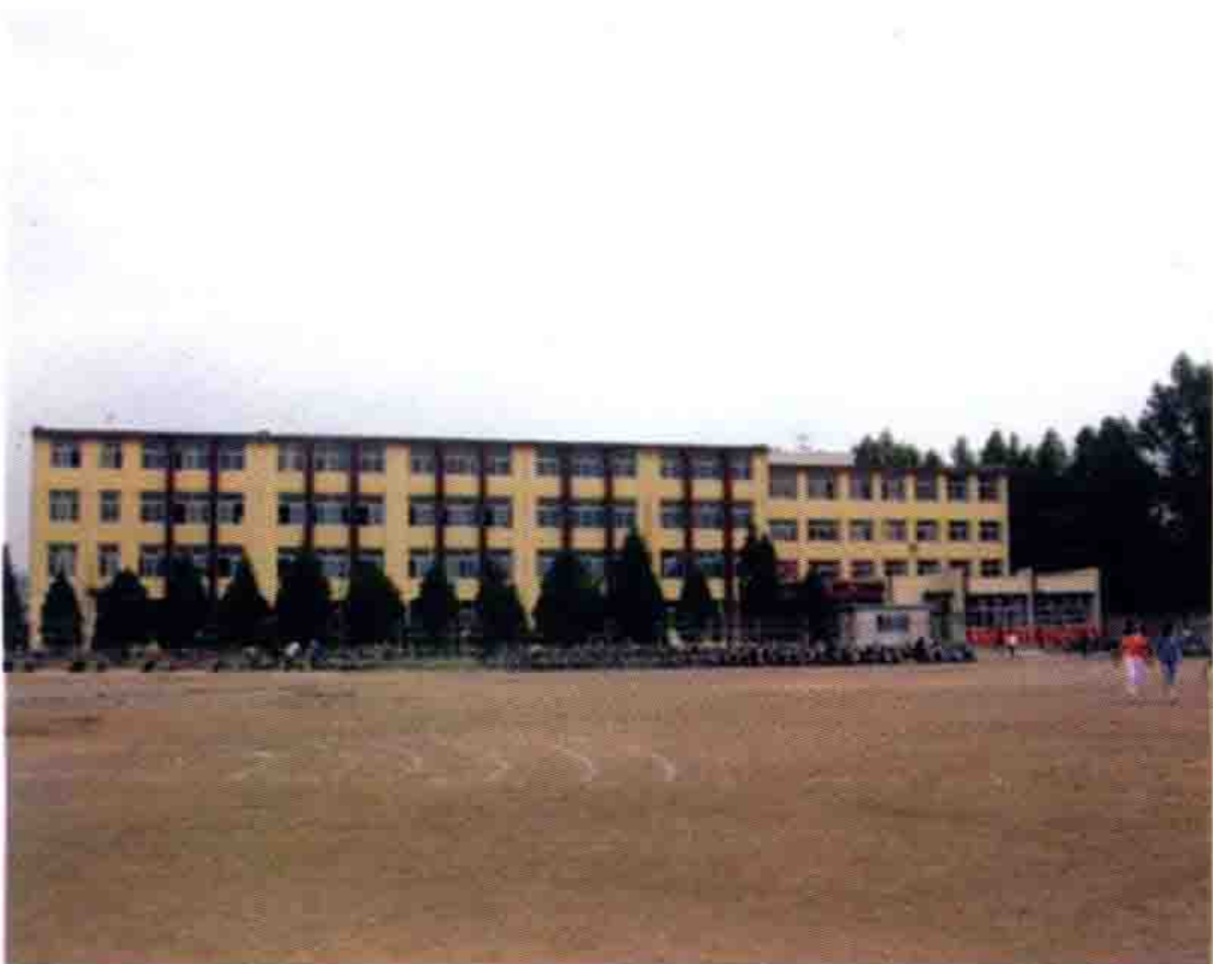
隆化县第一中学教学楼
