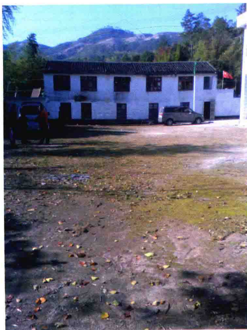
草白完小综合楼
