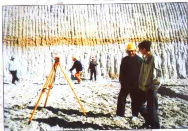
顶山隧洞出口段地质情况，施工人员在测量开挖边线与检查开挖质量
