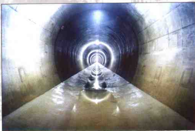
混凝土衬砌完成后，顶山隧洞全貌
