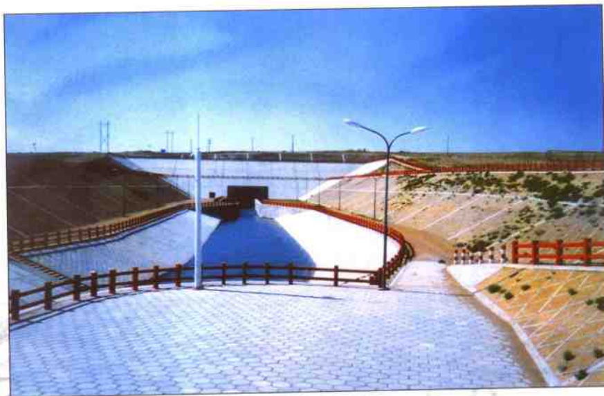
顶山隧洞进口全貌
