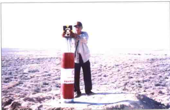
在渺无人烟的戈壁滩中，测量人员进行放线，开始顶山隧洞的建设
