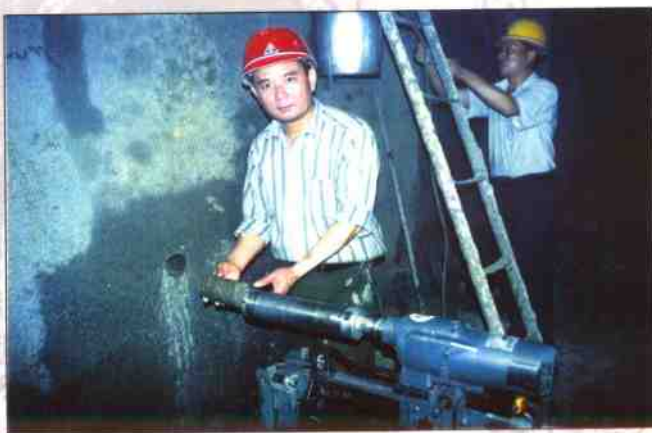
顶山隧洞 II 标段试验站人员和驻竖井技术人员在7号竖井上游段对一次支护喷射混凝土钻芯取样进行质量检查
