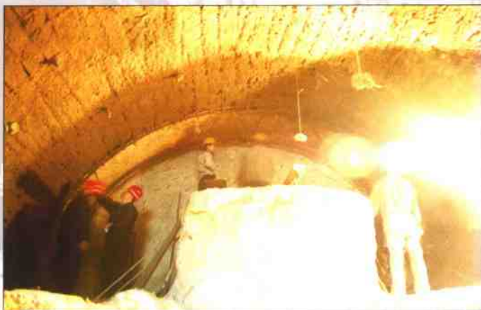
顶山隧洞实行分部开挖，上导洞开挖后立即进行一次支护。照片为上导洞开挖与一次支护后的情况，喷射混凝土壁面平整，格栅拱架安装质量优良
