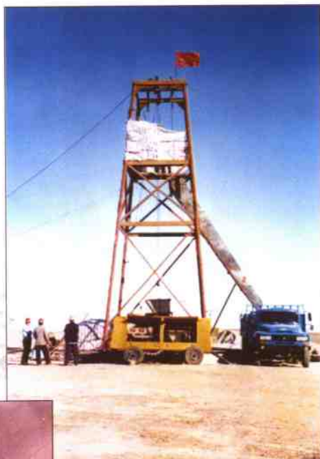
顶山隧洞施工竖井全貌
