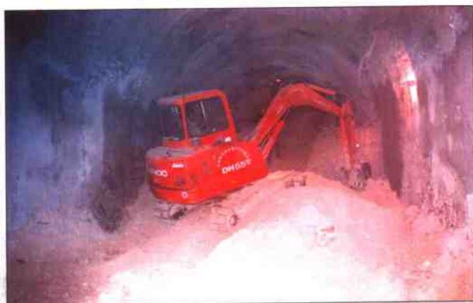
顶山隧洞 I 标段进口工作面液压挖掘机正在进行开挖施工中
