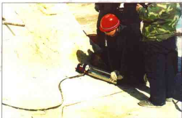
顶山隧洞出口进行自进式锚杆拉拔试验
