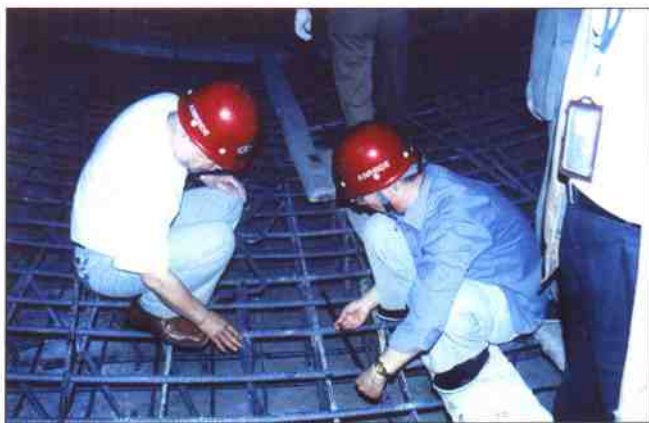
水利部质量监督站和业主在检查钢筋绑扎质量
