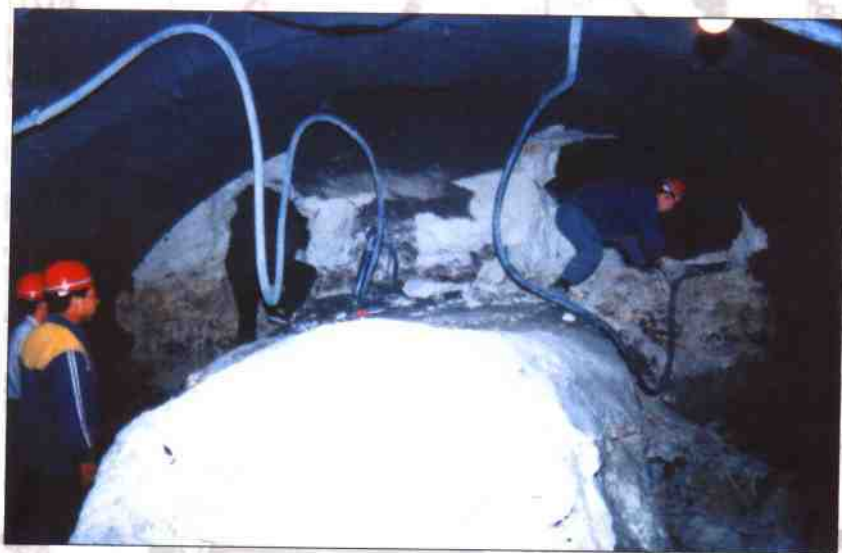
顶山隧洞由8个施工竖井和进出口共18个工作面同时相向开挖施工。照片为相邻工作面的贯通施工情况
