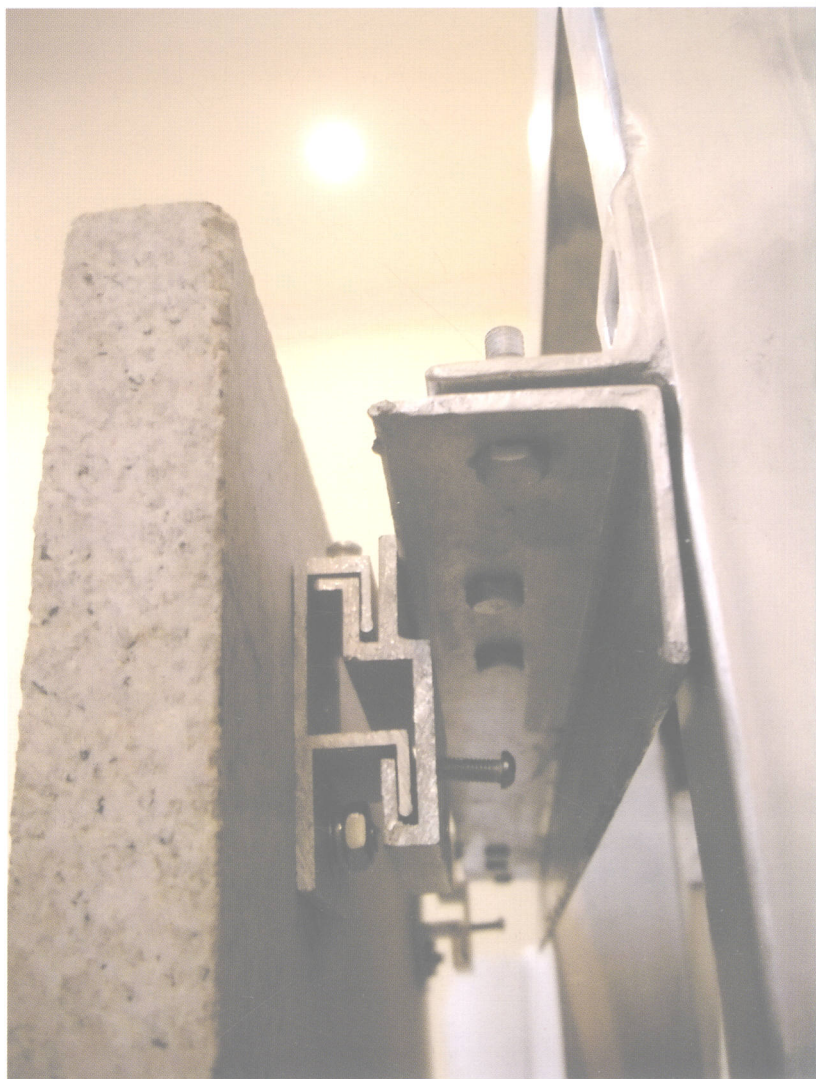
图 1-19b 另一种大型石材的干挂法。
