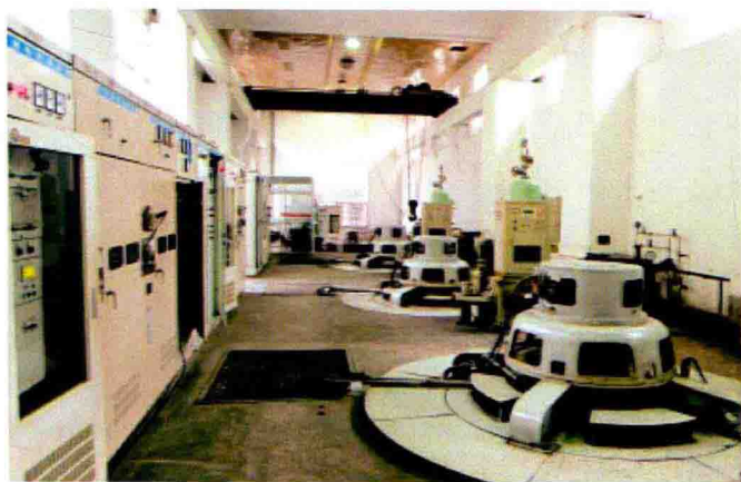
2005 年高坑电站新建机房
