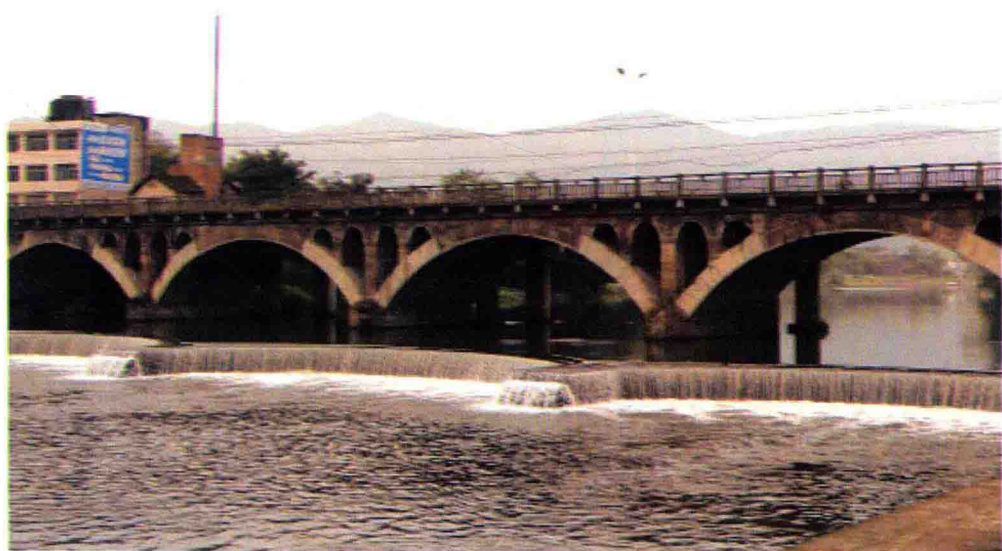
1960 年旧县大桥建成为单行道，2001 年改造为双行车道
