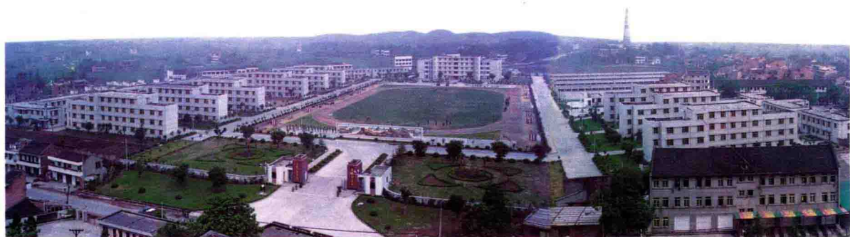
铜梁县军地换地工程——“962”工程全貌
