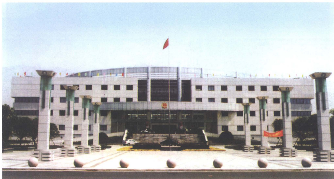
瓶窑镇政府办公大楼（2006年）
