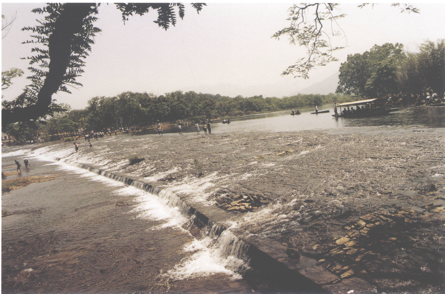
灵渠小天平坝泄水现状
