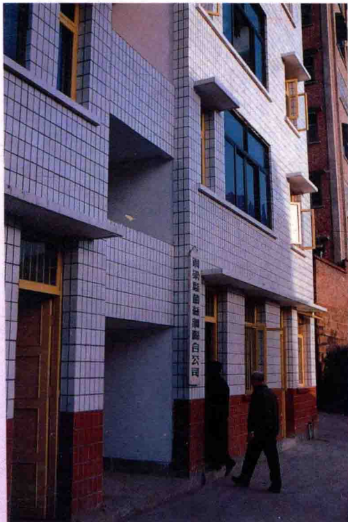
銅梁縣繭絲綢聯合公司辦公樓
