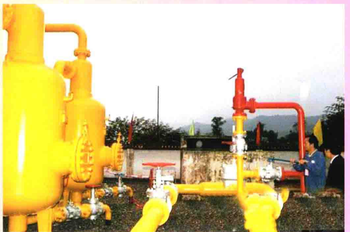
▲2008年10月31日，忠县至丰都 \phi 325 MM天然气管线工程全面竣工通气，日供气达16万立方米。
