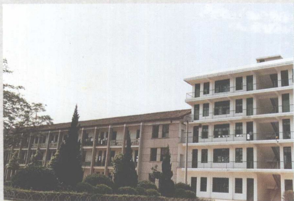
扩建后的教学大楼
