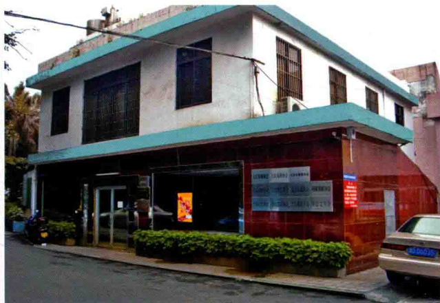
▲文化站办公楼左侧面
