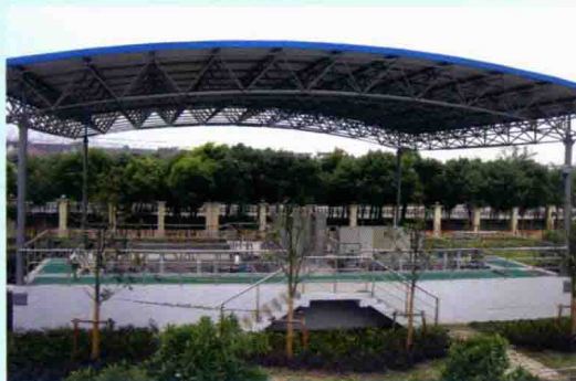
浦华纤维转盘滤池在硕放污水处理厂成功运行
