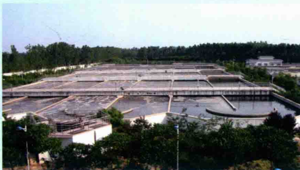
浦华下属 TOT 项目——开封污水处理厂
