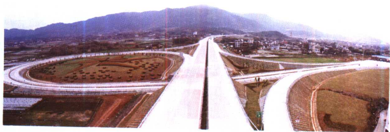
新建的漳龍高速公路
