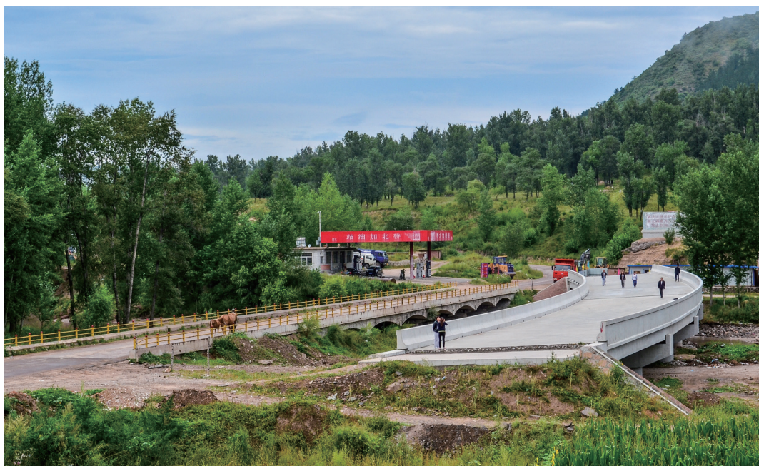
郭家屯滦河大桥
