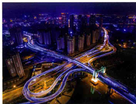
田安大桥北立交
