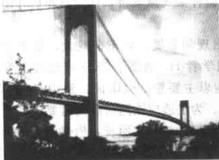
图 1-5 美国纽约韦拉扎诺悬索桥
