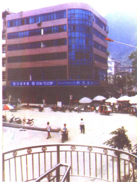
新建成的电信综合大楼
