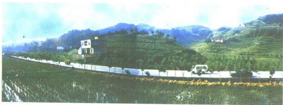
改造后的江兴公路一角
