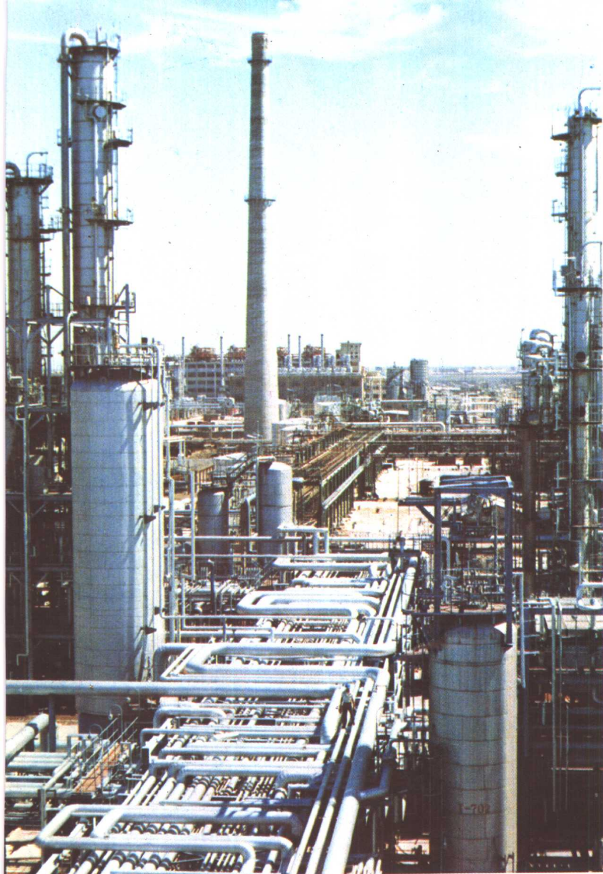
◀ 天津石油化纤总厂塔群管网
