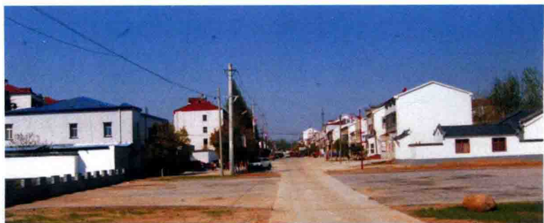
皇城村新农村建设及道路硬化一角
