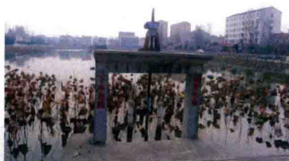
皇城村在2013年修建竣工的排灌提水闸
