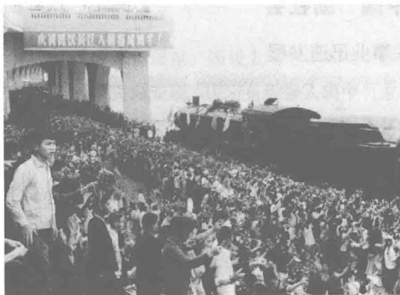
1957年10月15日,“一五”计划期间建设的武汉长江大桥举行通车典礼,武汉人民热烈欢迎第一列即将驶过长江的火车。
