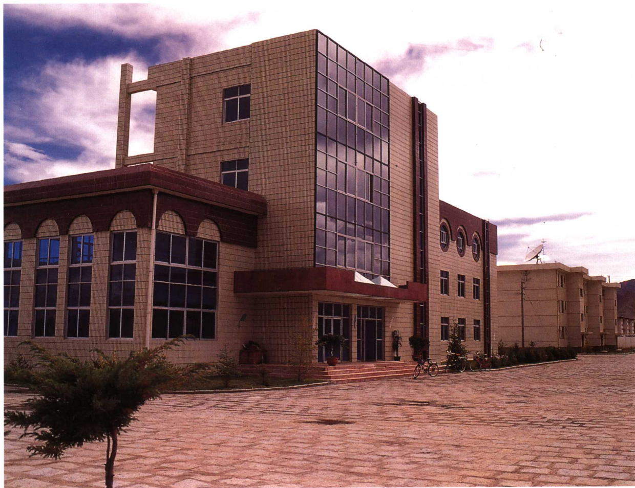
日喀则市自来水工程被当地藏族居民称为“民心工程”
