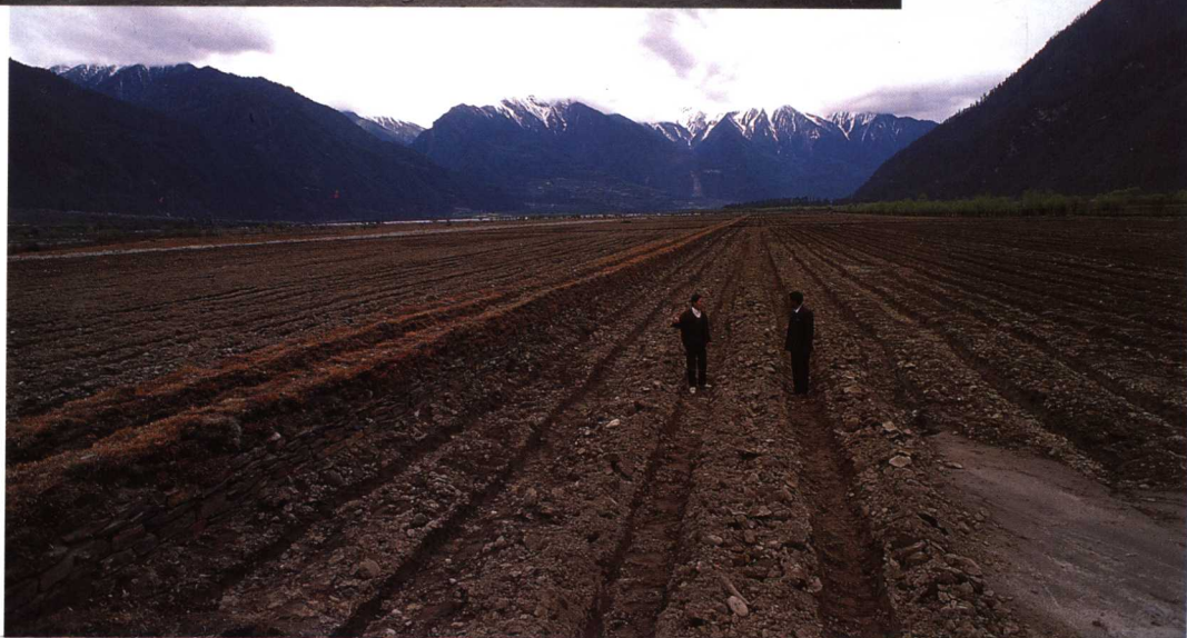
易贡草场改造工程新建了一座640千瓦的电站，新开发草场140亩
