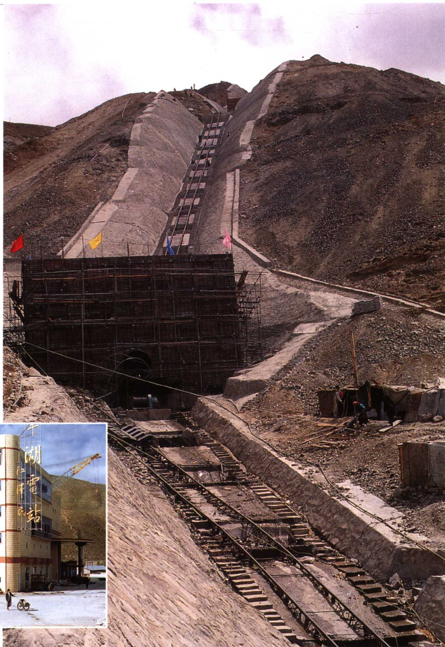
海拔最高的羊湖电站，其引水洞工程 正在加紧施工
