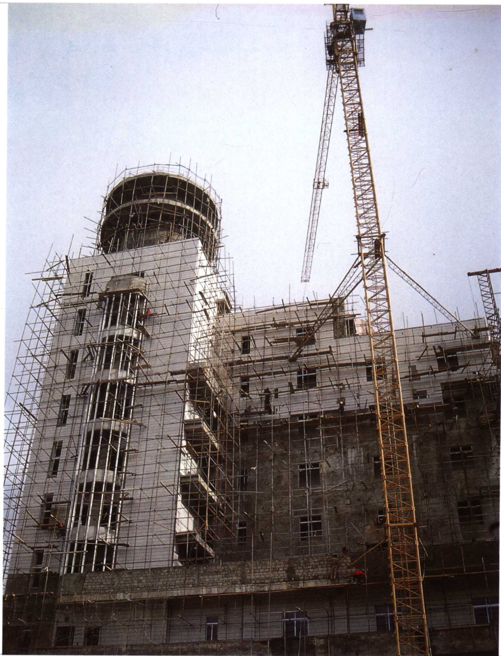
建设中的拉萨长途电话枢纽 工程大楼
