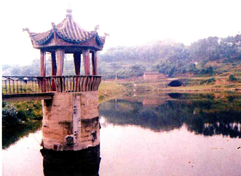
◀ 桥亭水库放水竖井工程
