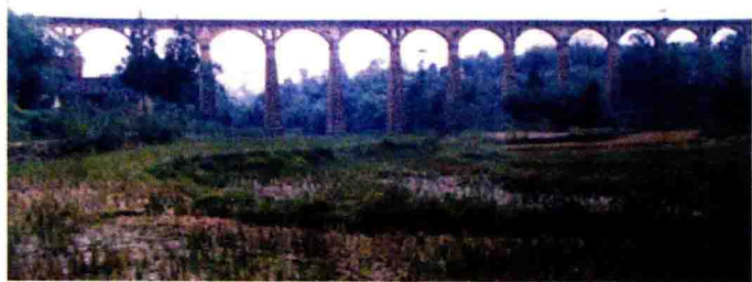
◀ 桥亭水库董家大沟渡槽
