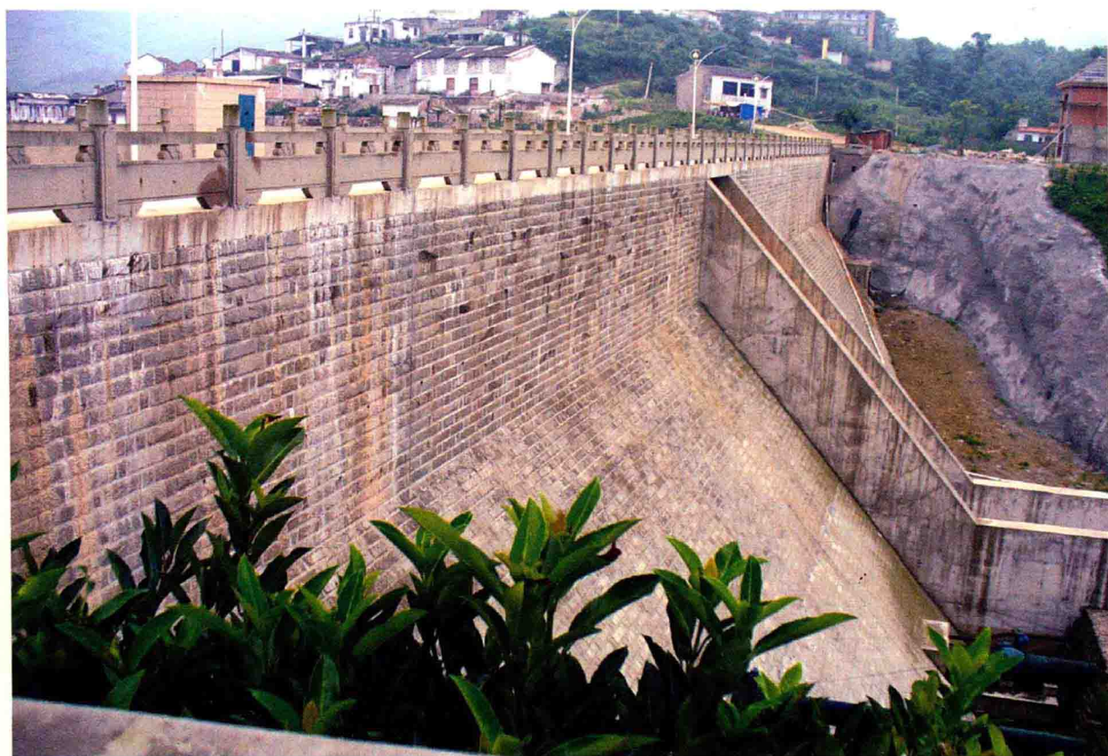
▲ 玄天湖水库大坝外坡
