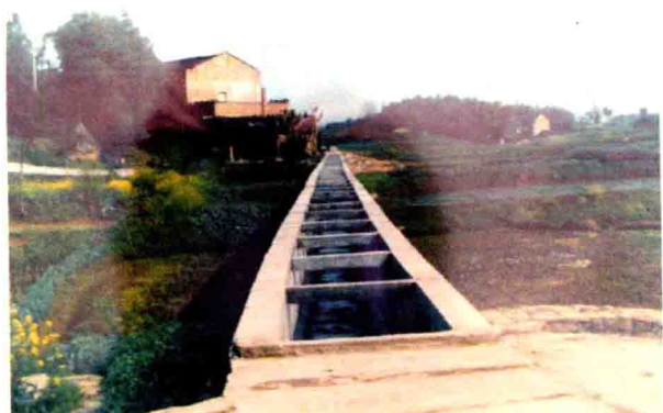
▲黄家钢混结构渡槽
