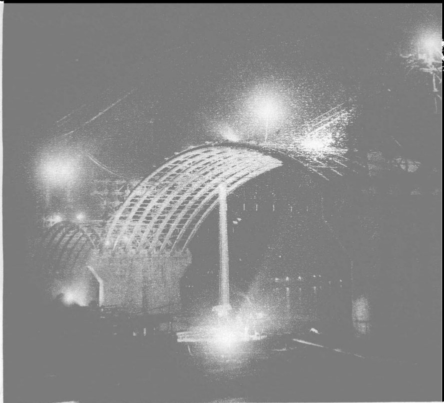
日夜奋战，力争加速大桥建设。
