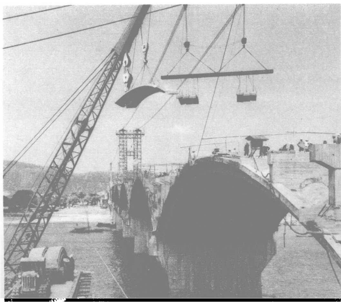
工人们制造了铁“扁担”，提高了小拱圈、立柱吊装工效。
