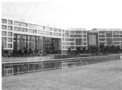
(a) 某学校教学楼
