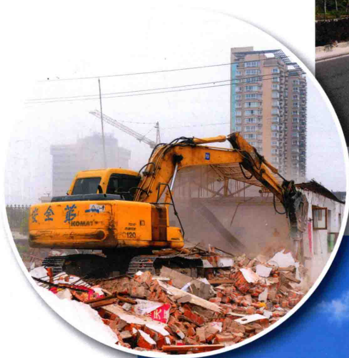
体育中心拆违现场
