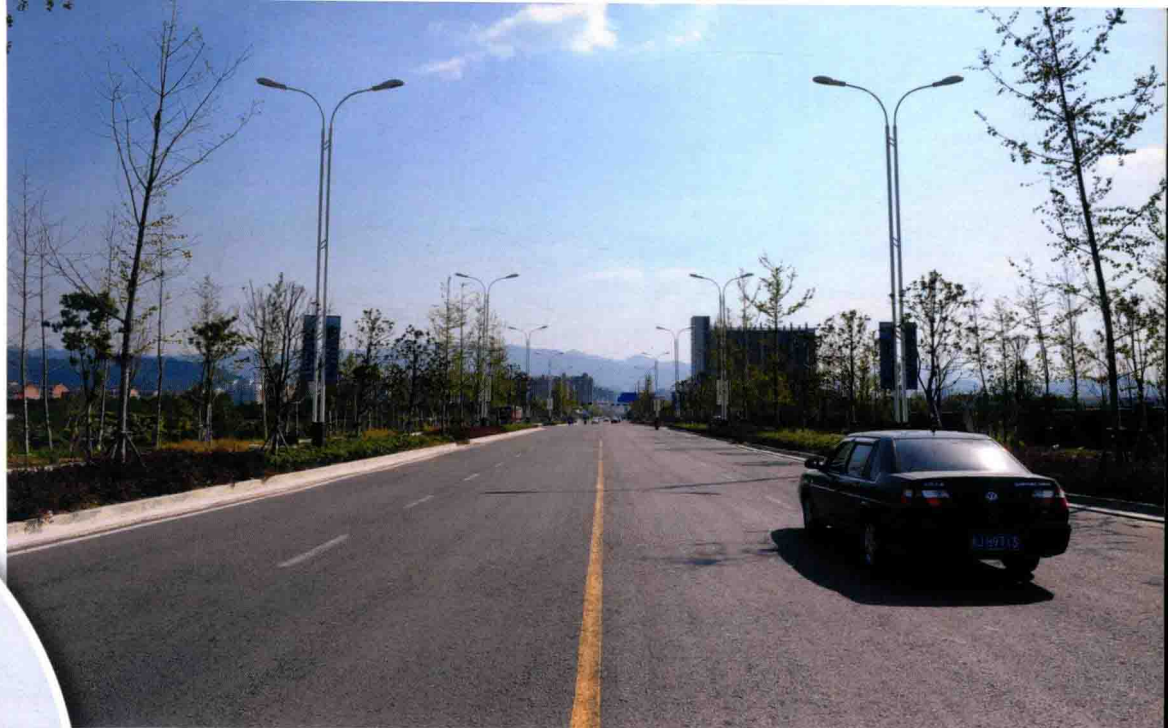
西三路占地35亩，2012年11月 动工，2013年2月完工
