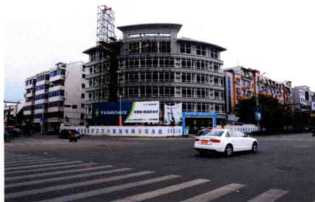
安洲中学综合楼占地2亩，2011年9月动工建设
