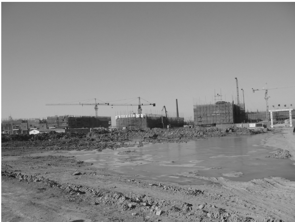
2005年12月6日,施工现场
