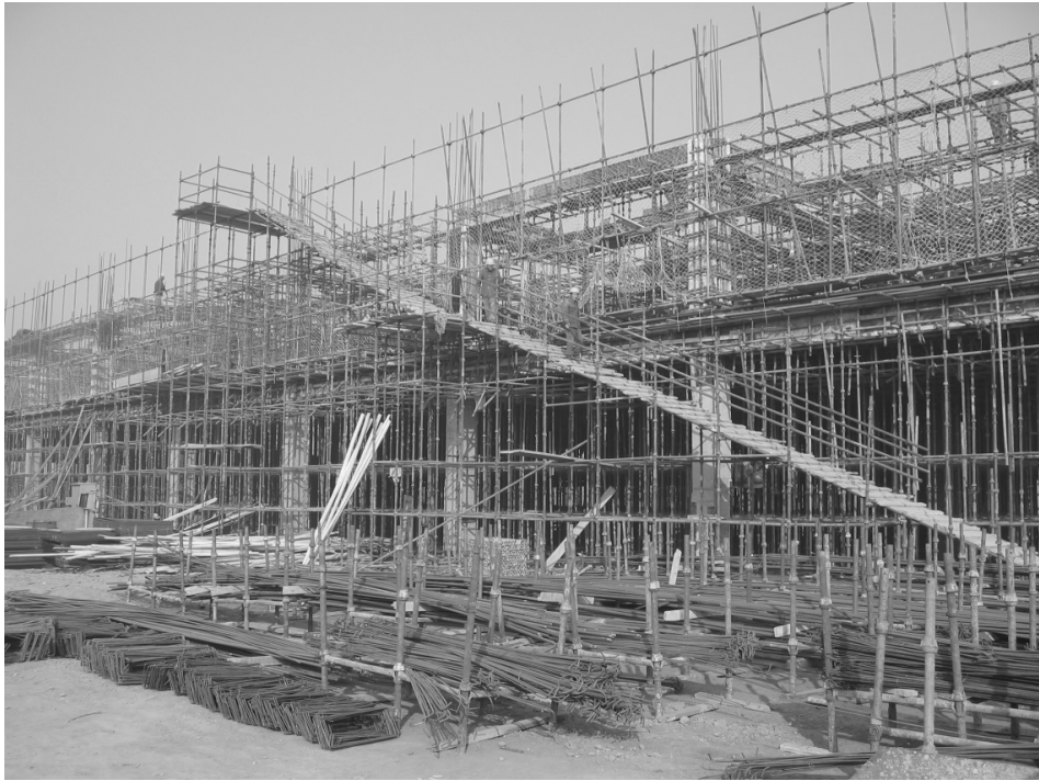
2005年11月22日,施工现场
