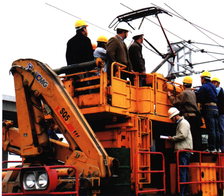
中铁一局集团电务工程有限公司承建的 广州地铁3号线电气化工程进行冷滑试验
