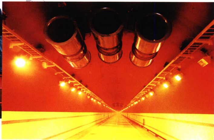
中铁一局集团电务工程有限公司承建的 公路隧道通风、照明、消防工程
