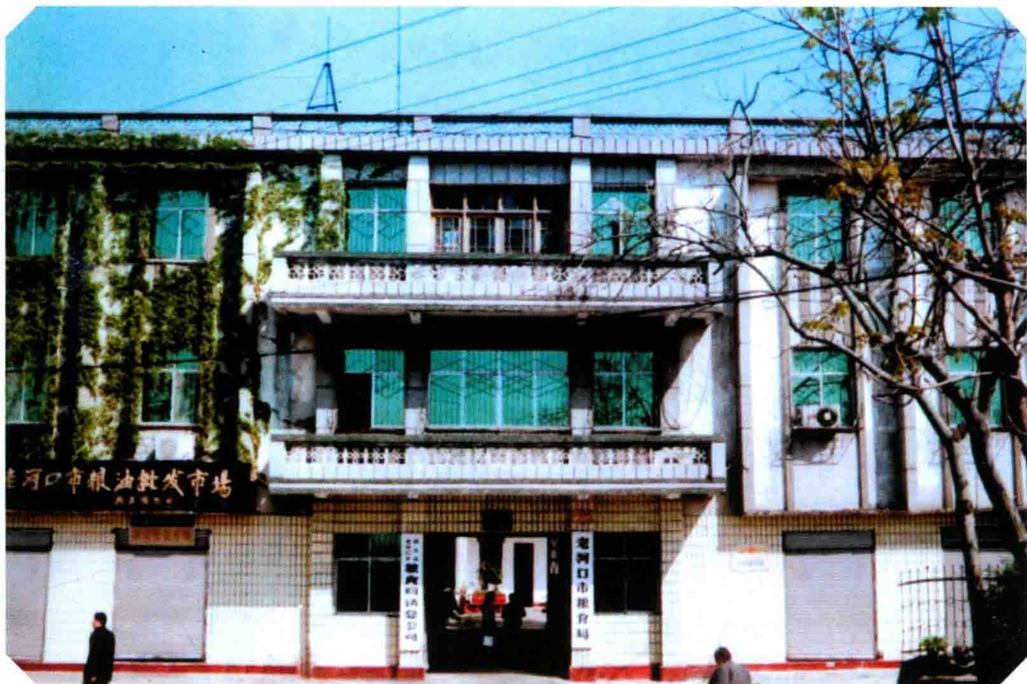
老河口市粮食局办公大楼（五福楼36号）
