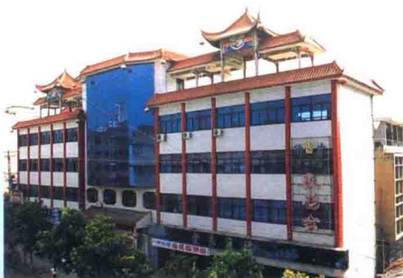
▲ 枣阳市粮食局门面楼
