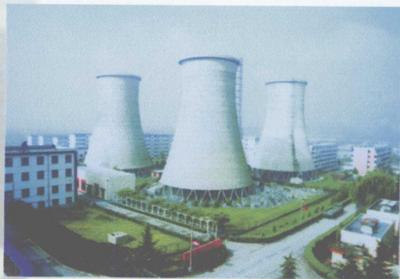
抓住有利时间，加速推进煤电联营，图为年消耗煤矸石约40万吨的煤矸石电厂
