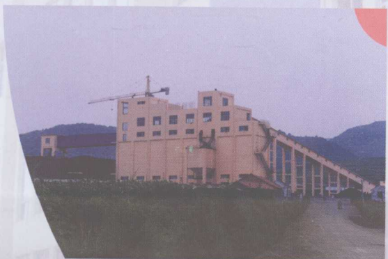
南阳煤矿120万吨/年筛分楼
