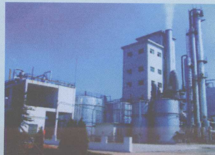
采取循环经济模式建成的联产甲醇、甲醛
