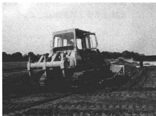
图 1-3 推土机在平整场地
