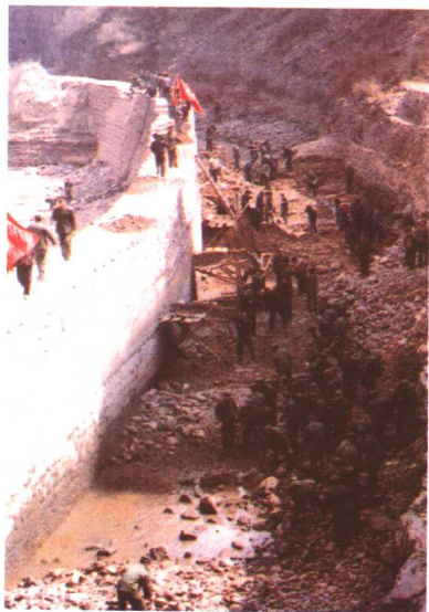
1993年3月军民共同参加红旗渠技改施工
