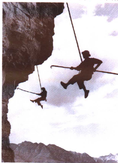
红旗渠修建工地上除险队员悬空作业
