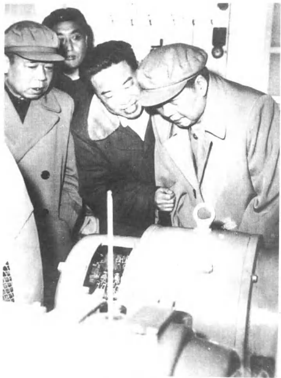
1960年3月14日,毛泽东视察金华双龙水电站。
