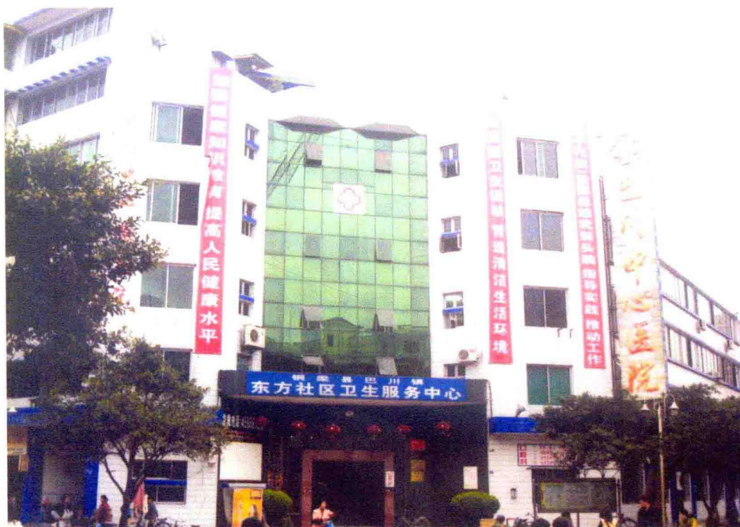
■ 巴川中心卫生院业务大楼
