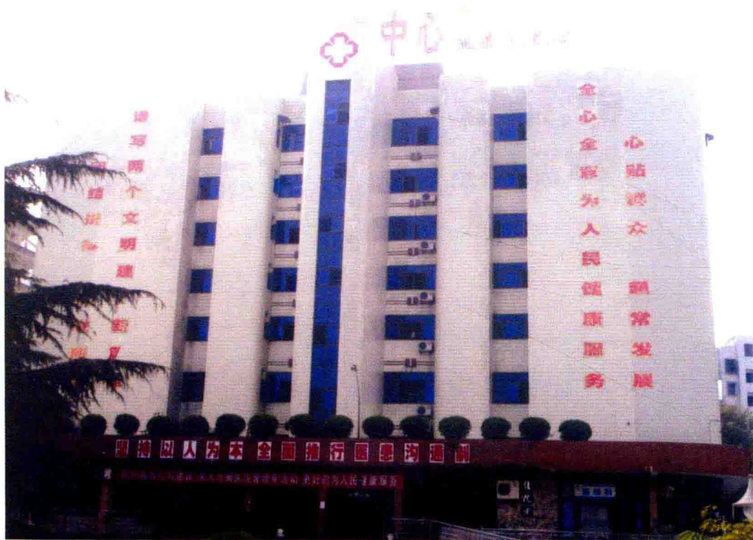
■ 县人民医院住院大楼
