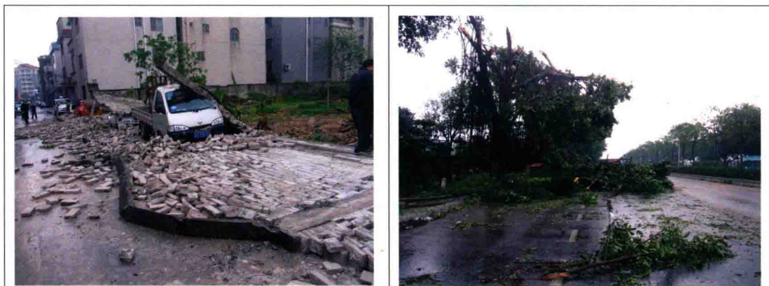
图 13 3 月 30 日伦教街道倒塌的围墙和道路上折断的树木
