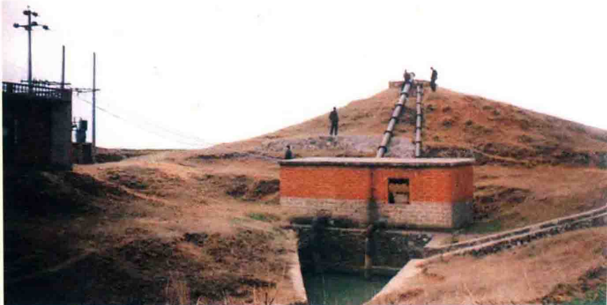
“农业机械威力大，谱写时代新神话 —— 牵着‘龙王’上山岗，引来绿水浇庄稼”。 图为枣阳市 691座抽水泵站之一景。
