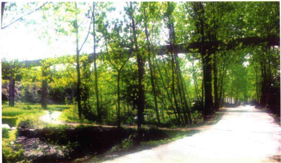
永丰水库西干渠横空渡槽
