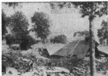
图 4 凤凰路开滦工房 10# 楼的倒塌
