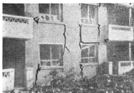
图 23 窗下墙两侧的竖直缝
