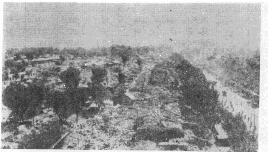
图 3 新华东路房屋震害
