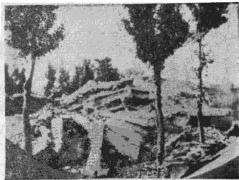
图 5 矿冶学院理化楼的倒塌
