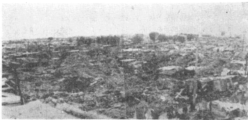
图 2 路南区的震害
