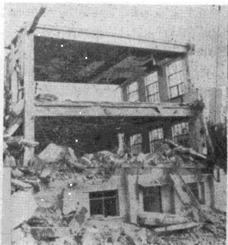
图 14 交际处 5# 楼大餐厅部份两端垮倒塌
