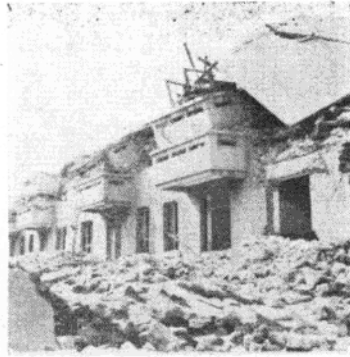
图 11 西北井六四楼 4# 楼上两层倒塌
