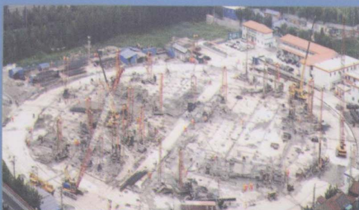
在建上海逆作法施工最深的工程
