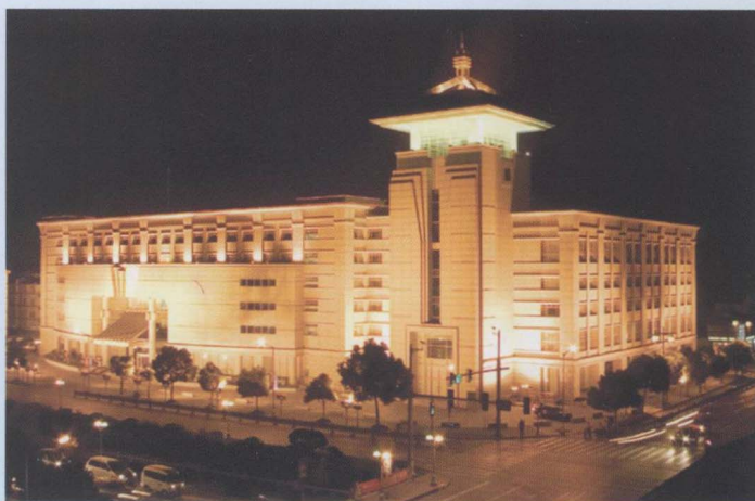
苏州国税综合业务大楼-2004 年度鲁班奖
