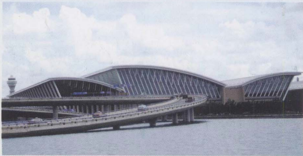
EPC 工程总承包 - 上海浦东国际机场
