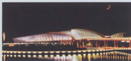
浦东国际机场航站区
