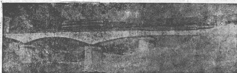
图10 孙水河五号桥（跨度64米悬臂梁桥）
